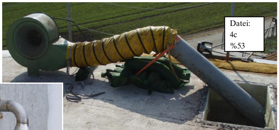
Als Frischluftlüfter können Sie auch ein Getreideluftgebläse nutzen. Die Lutte sollte mindestens 5 m lang sein.
