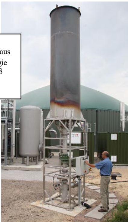
Abgasfackeln sollten in einem ausreichend großen Abstand zur Anlage selbst montiert werden.
