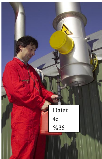
Warten Sie regelmäßig Ihre Über- und Unterdrucksicherung.
