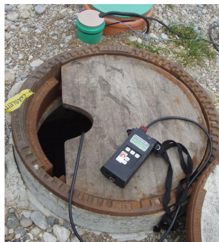
Bevor ein Schacht betreten wird, sollte eine Gasmessung durchgeführt werden. Vergessen Sie auch nicht, zu lüften.
