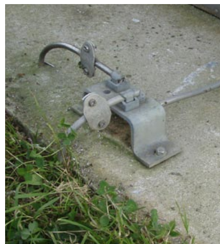
Wichtig: Eine Biogasanlage benötigt nicht nur einen äußeren Blitzschutz, sondern auch einen Potentialausgleich.
