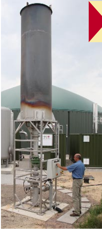
Eine Notfackel sollte in Abhängigkeit von ihrer Größe in ausreichendem Abstand zum Fermenter aufgestellt werden.
