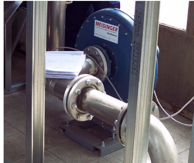
Fachmännisch verbaute Kompensatoren an einem Verdichter (links)
