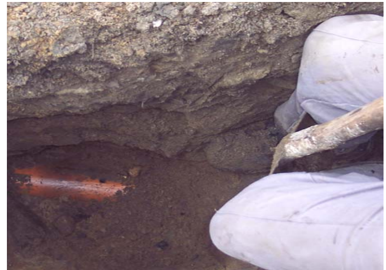
Handelsübliches KG-Rohr als Gasleitung
