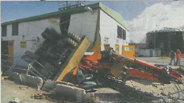
Halbe Million Euro Schaden: Ein Schauflerbagger kracht gestern in die zentrale Stromversorgung. Hinzmann des. ▶ Seite 5
