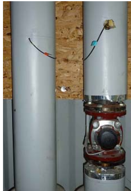
Foto: Wärmemengenzähler (KWK-Bonus)
