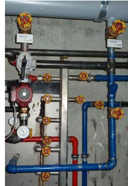
Foto: Fermenterheizung mit Pumpe und Mischer
