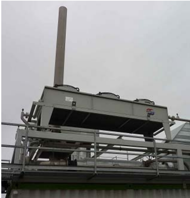
Foto: Notkühler des BHKW
