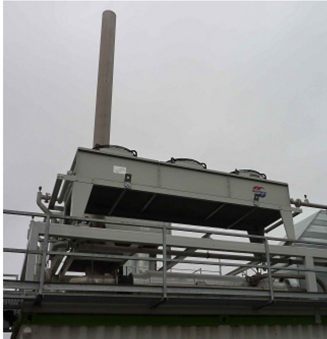
Foto: Notkühler des BHKW
