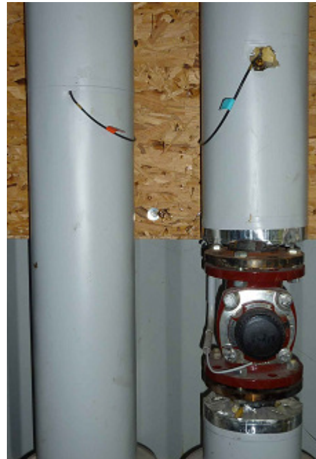
Foto: Wärmemengenzähler (KWK-Bonus)
