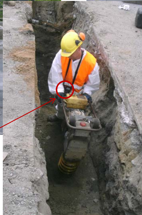
Verdichtungsarbeiten im Leitungsgraben aufzwb. In einer Altablagerung [DAS-IB GmbH, 2009]
