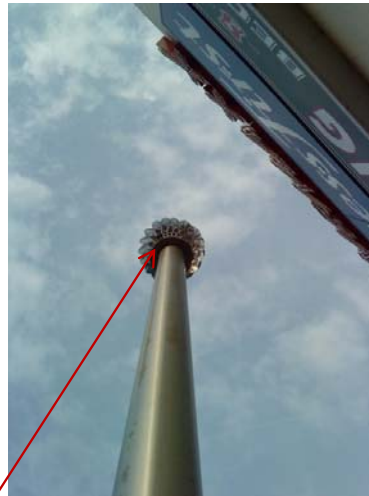
Entlüfter auf einer Altablagerung [DAS-IB GmbH, 2010]
