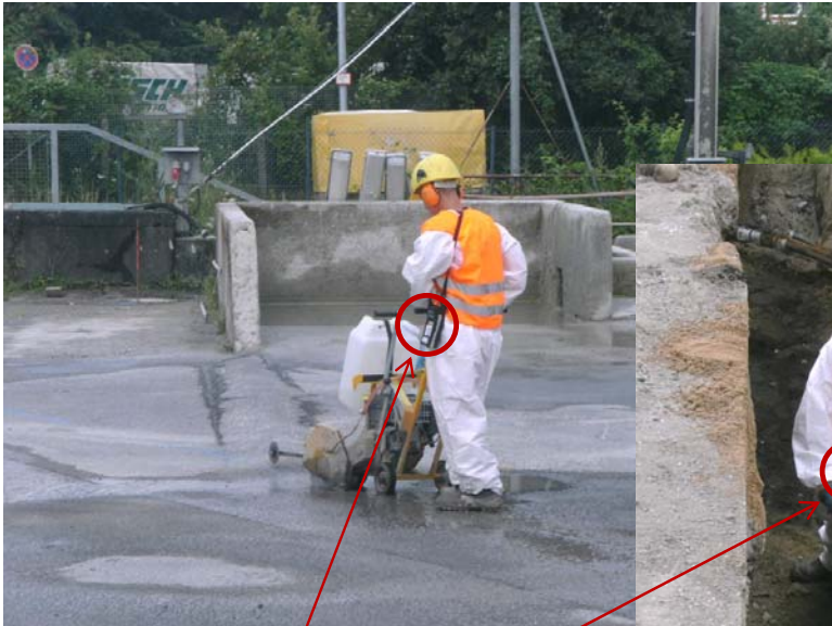
Schneiderarbeiten an einer Betonoberfläche auf einer Altablagerung [DAS-IB GmbH, 2009]
