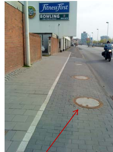
Schächte für Revisionsöffnungen Absaugung
