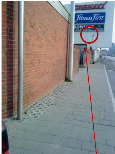
Entlüftungssteine und Entlüfter auf einer Altablagerung [DAS-IB GmbH, 2010]
