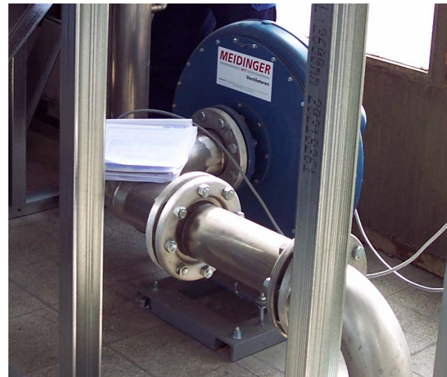
Fachmännisch verbaute Kompensatoren an einem Verdichter (links)
