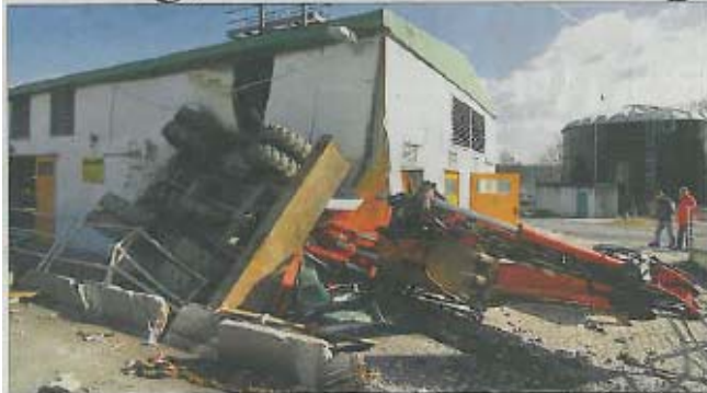
Halbe Million Euro Schaden: Ein Schaufelbagger kracht gestern in die zentrale Stromversorgung.
