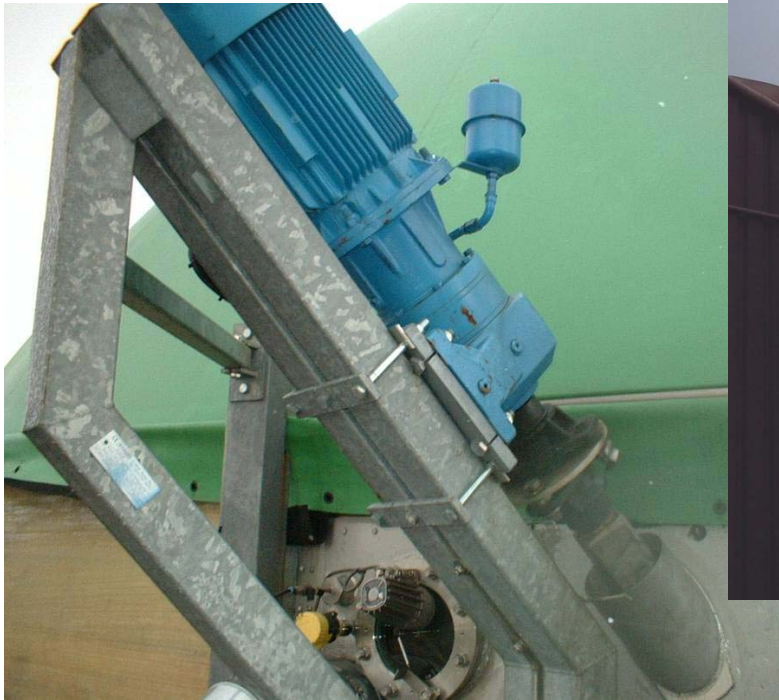
Gegen Schwingungen gesichertes Rührwerk
