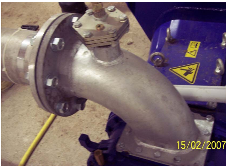
Übergang Edelstahl / Stahl verz. / Stahl lackiert
