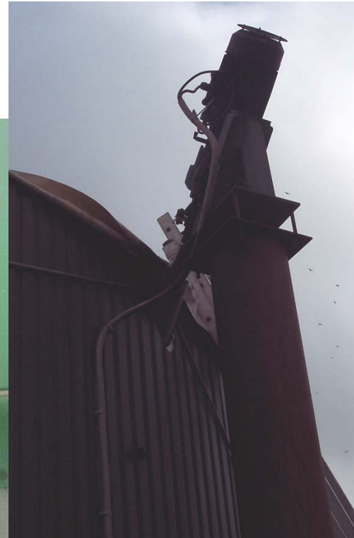
nicht gesichertes Rührwerk - > Hebelwirkung
