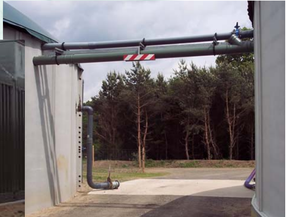
Pro-forma-Sicherung der Rohrbrücke
