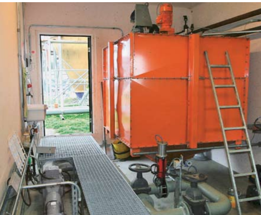
Anmischbehälter mit tödlicher H 2 S-Konzentration 2007. Foto: R. Lange
