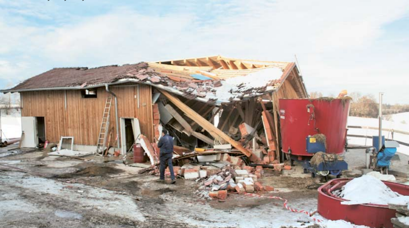
Havarierte Biogasanlage im Allgäu 2007. Foto: Udo Dietrich
