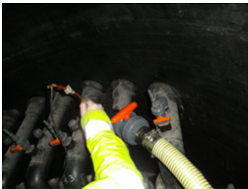
Abbildung 9: Flexible Rohrleitung
