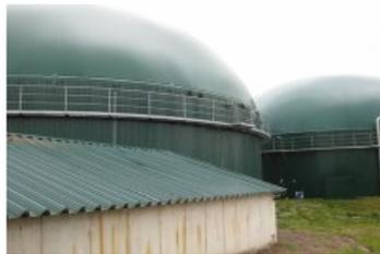
Der Versicherte war gemeinsam mit drei Kollegen mit dem Tausch von zwei Tauchmotorrührwerken eines Fermenters beauftragt worden. Um diese Arbeit ausführen zu können, musste das Gasspeichersystem (Tragluftdach) zu einem Teil geöffnet werden. Zu diesem Zweck wurde zunächst der mit Druck beaufschlagte Klemmschlauch drucklos gemacht. Nach einer Kontrolle auf
