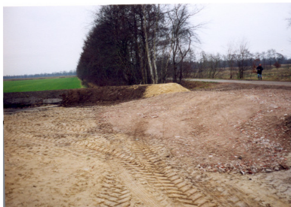
Umwallung einer Biogasanlage in der Fertigung
