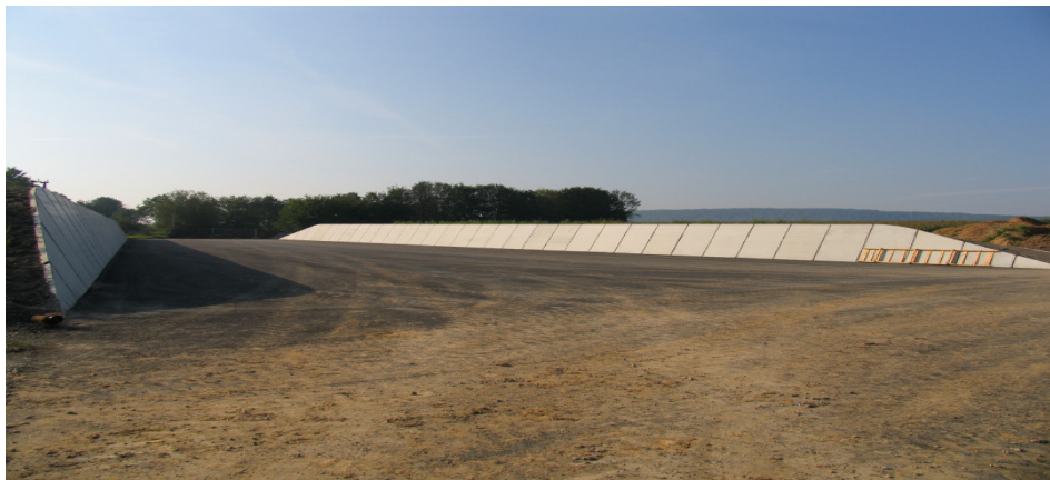
Fahrsilo nach der Trauensteiner Bauart – Vor der Beschickung
