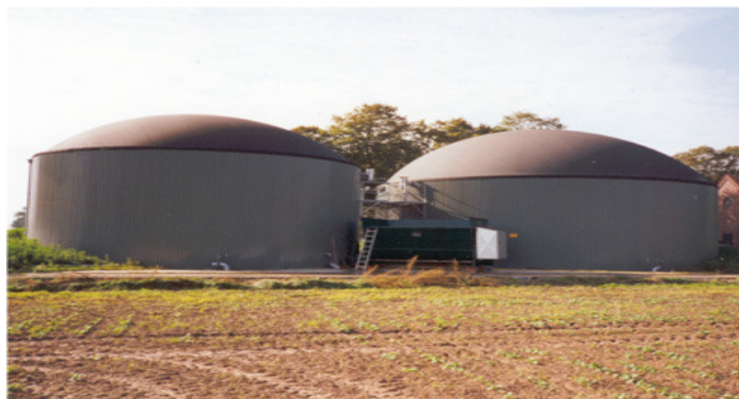
Fermenter und Lagerbehälter
