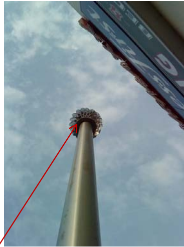
Abb. 13 Entlüfter auf einer auf einer Altanlage [DAS-IB GmbH, 2010]
