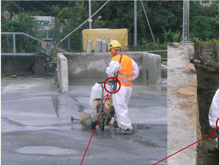
Abb.5 Schneidarbeiten an einer Betonoberfläche auf einer Altanlage [DAS-IB GmbH, 2009]
