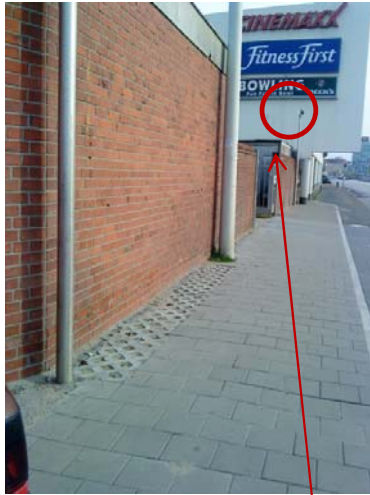
Abb.12 Entlüftungssteine und Entlüfter auf einer auf einer Altanlage [DAS-IB GmbH, 2010]
