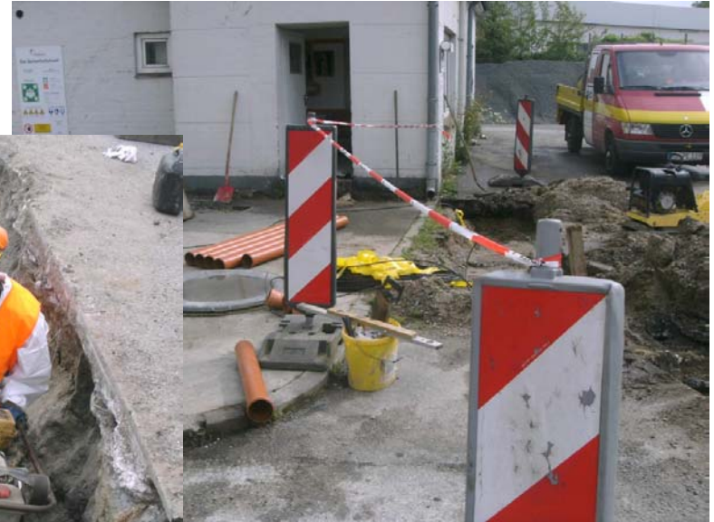
Abb.6 Baustelle auf einer Altanlage in einem Gewerbegebiet [DAS-IB GmbH, 2009]
