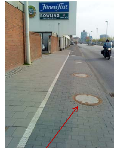
Abb. 14 Schächte für Revisionsöffnungen Absaugung
