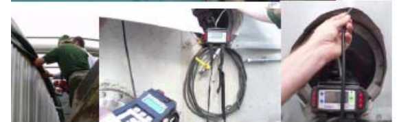
Bild 3 bis 6. Die Prüfgasentnahme ist gemäß obigen Bild gesichert aus der Abluftöffnung zu entnehmen. Im oberen Bild wird jedoch das Schutzluftpolster nicht komplett quer durchströmt. In der internen Bildreihe (Mitte und Rechts) sind sog. Personenschutzmeßgeräte zur Messung verwendet worden, die vor einer gefährlichen explosionsfähigen Atmosphäre (geA) warnen und nicht Konzentrationen im ppm - Bereich (wie im linken Bild untere Bildreihe und auf dem Bild oben) messen können.
