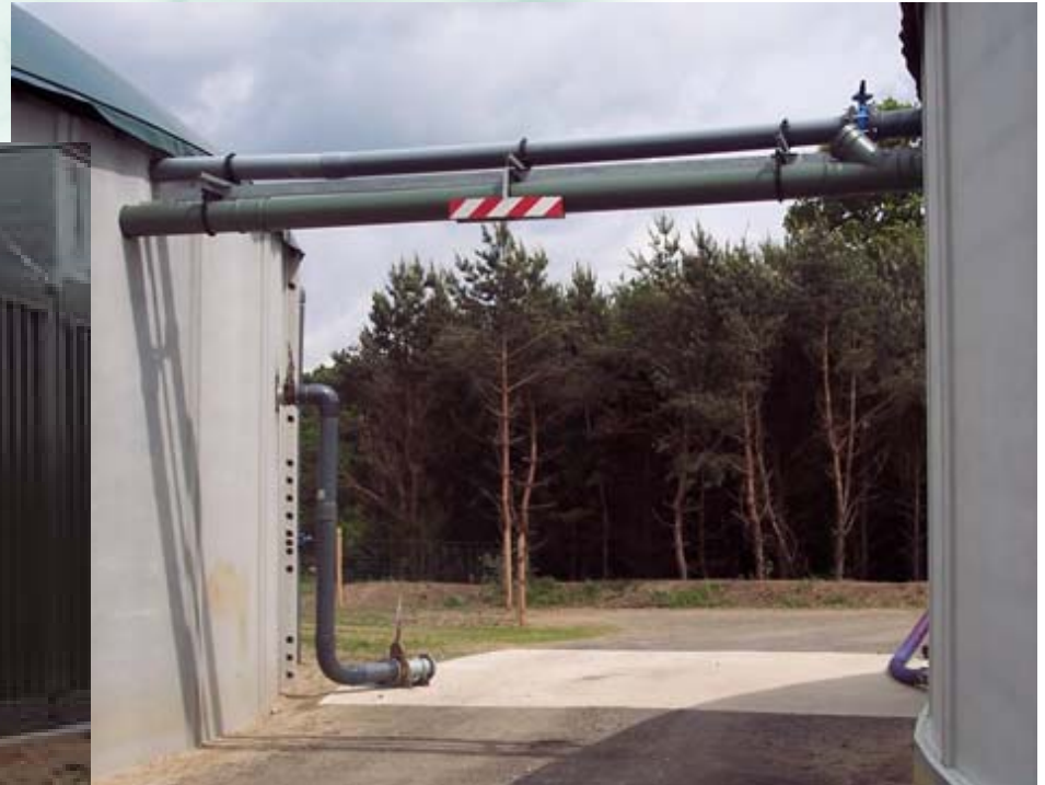
Pro-forma-Sicherung der Rohrbrücke
