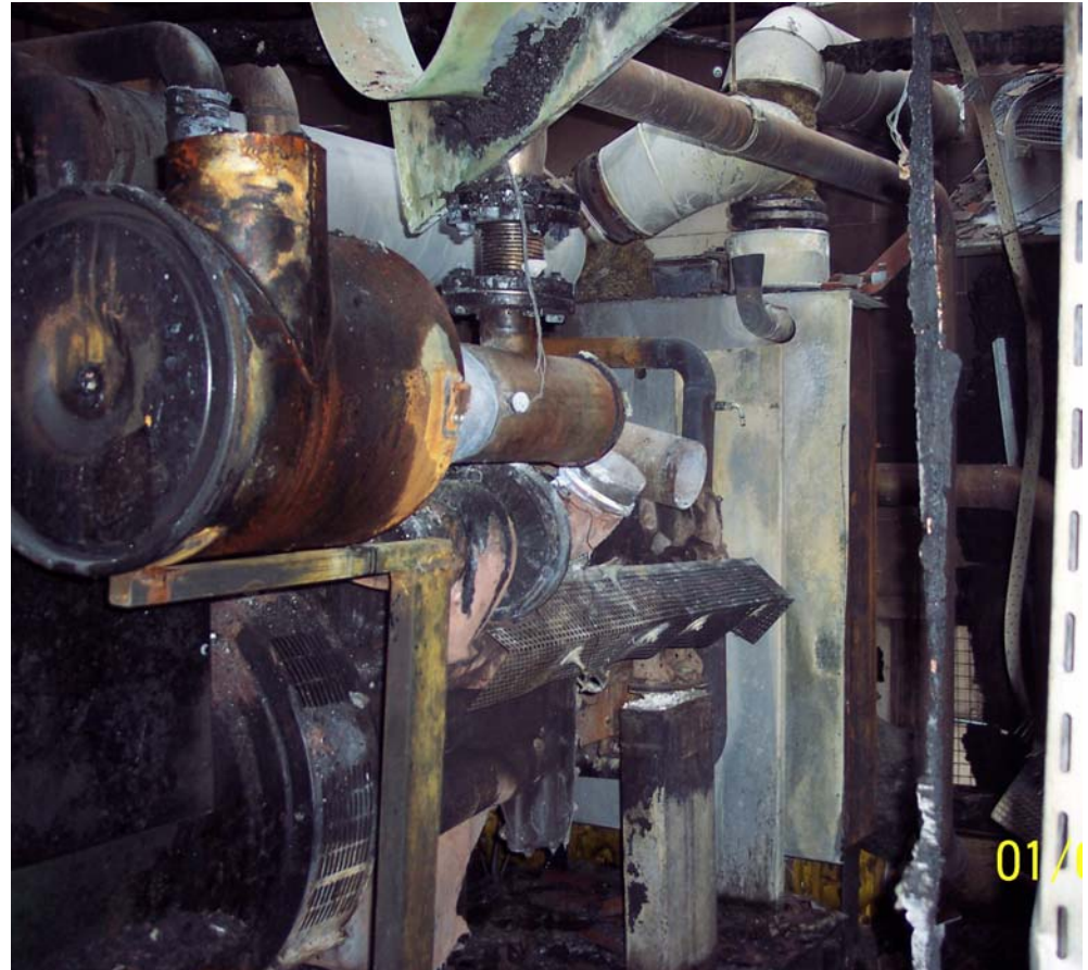
Brandschaden an einem BHKW-Gebäude
