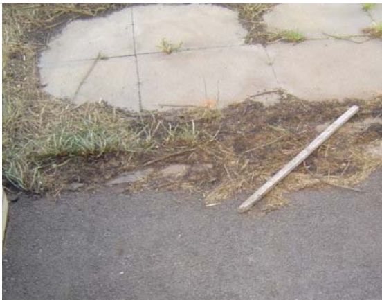
Brandspuren vor dem Gebäude
