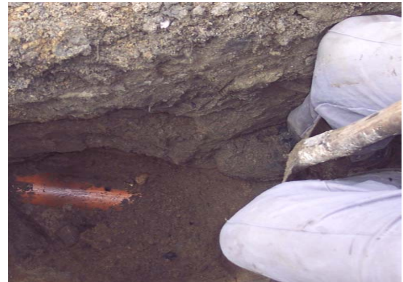
Handelsübliches KG-Rohr als Gasleitung
