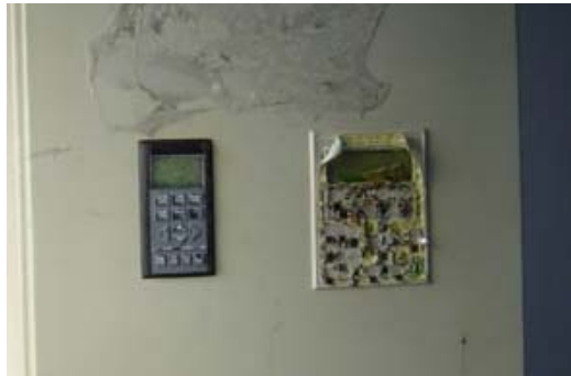
Schaden am Steuerschrank
