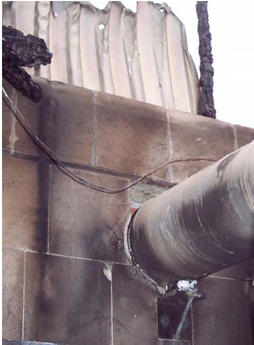
Brandschaden an einem BHKW-Gebäude
