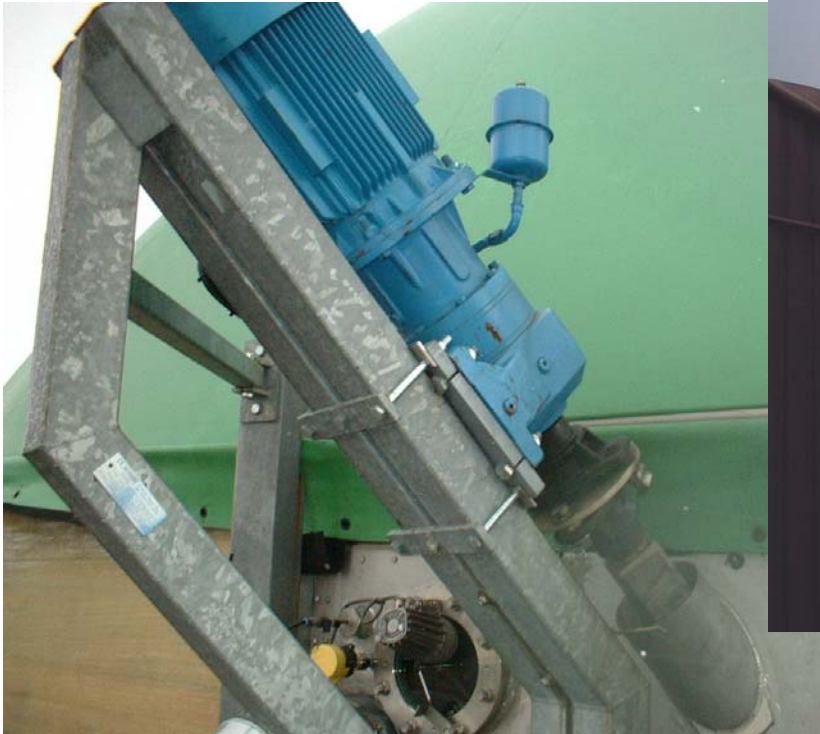
Gegen Schwingungen gesichertes Rührwerk
