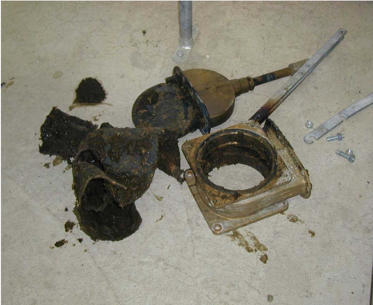
Beschädigtes Ventil und Fremdkörper
