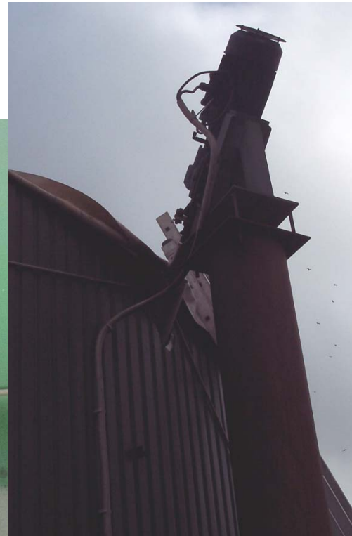
nicht gesichertes Rührwerk - > Hebelwirkung
