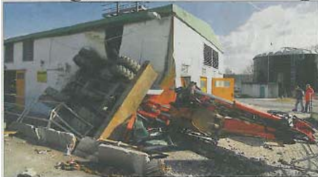
Halbe Million Euro Schaden: Ein Schauflerbagger kracht gestern in die zentrale Stromversorgung.
