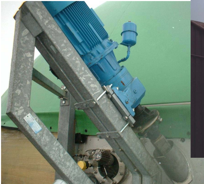
Gegen Schwingungen gesichertes Rührwerk
