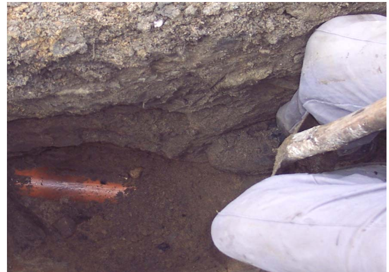
Handelsübliches KG-Rohr als Gasleitung
