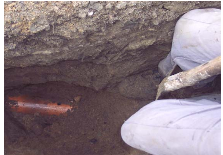
Handelsübliches KG-Rohr als Gasleitung
