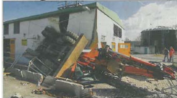
Halbe Million Euro Schaden: Ein Schaufelbagger kracht gestern in die zentrale Stromversorgung. Hirzmann
