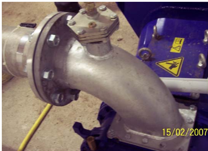
Übergang Edelstahl / Stahl verz. / Stahl lackiert
