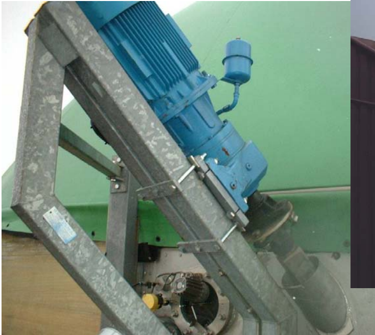
Gegen Schwingungen gesichertes Rührwerk
